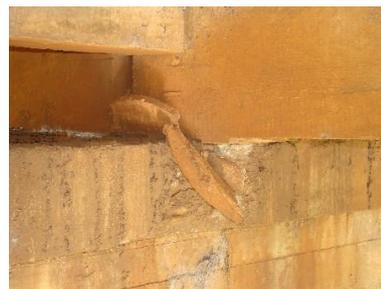
**Figura 9** – Aparelho de apoio de placa de chumbo seccionado
