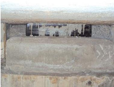
**Figura 2** – Aparelho de apoio de elastômero impedido de se movimentar,
