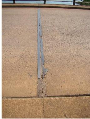
**Figura 15** – Corrosão nas cantoneiras metálicas de proteção das bordas das juntas
