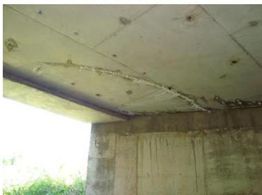
**Figura 38** – Processo de lixiviação em fissura localizada sob o tabuleiro de ponte
