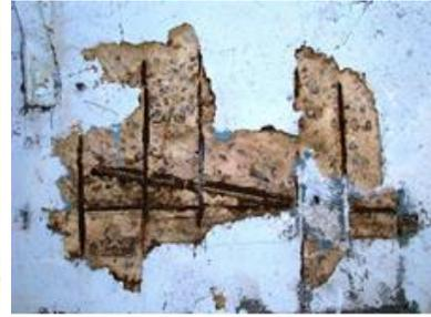
**Figura 34** – Armaduras expostas e corroídas na região do encontro de ponte
