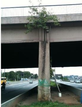
**Figura 11** – Presença de vegetação na abertura da junta de dilatação
