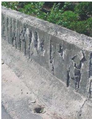
**Figura 43** – Barreira rígida com destacamento de concreto nos locais com armaduras corroídas.
