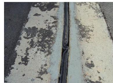
**Figura 13** – Descolamento entre o material elastomérico da junta e o lábio polimérico
