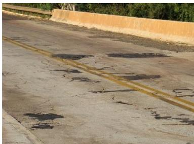
**Figura 40** – Pavimento rígido de concreto danificado, apresentando fissuras.
