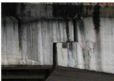
**Figura 29** – Fissuras inclinadas nos cantos da ligação Gerber
