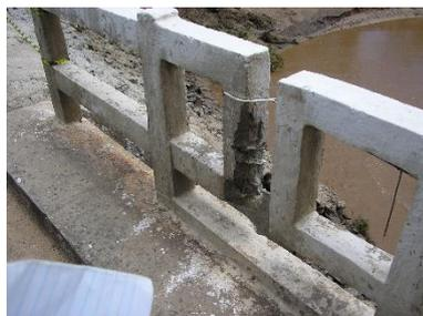
**Figura 44** – Proteção lateral de concreto armado com danos no cobrimento de concreto.
