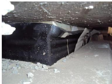
**Figura 6** – Falta de aderência entre a viga longitudinal com o aparelho de apoio, provocando o deslizamento entre as interfaces dos materiais
