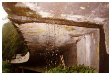
**Figura 12** – Infiltração de água através da junta de dilatação
