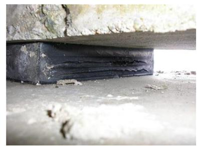
**Figura 41** – Aparelho de apoio com elastômero apresentando rasgos
