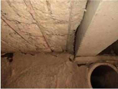
**Figura 32** – Destacamento do cobrimento de concreto e armaduras expostas e corroídas em tabuleiro de ponte
