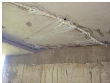
**Figura 39** – Detalhe da lixiviação mostrada na Figura 38
