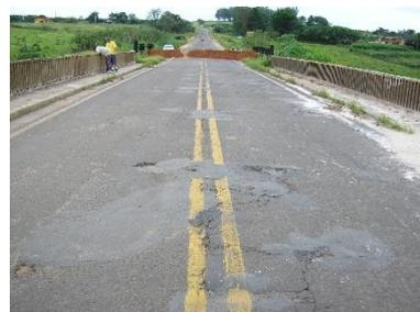
**Figura 42** – Pavimento asfáltico de ponte danificado, apresentando fissuração e locais com partes soltas.
