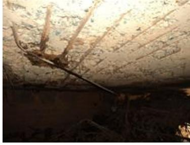
**Figura 33** – Destacamento do cobrimento de concreto e armaduras expostas e corroídas em tabuleiro de ponte
