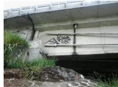
**Figura 22** – Tubulação de drenagem ineficaz, permitindo o escoamento das águas pela lateral da viga
