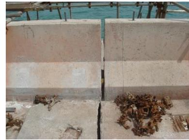
**Figura 16** – Barreira rígida invadindo a abertura da junta, prejudicando a movimentação e ausência de material de vedação da junta de dilatação
