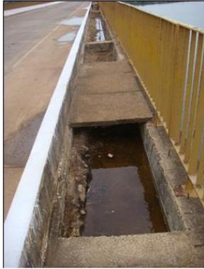
**Figura 20** – Acúmulo de água na região dos passeios, devido a caimentos inadequados
