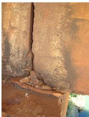
**Figura 8** – Aparelho de apoio de placa de chumbo deteriorado e viga apoiada de forma precária
