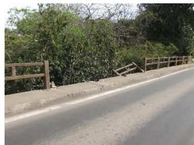
**Figura 45** – Trecho de ponte sem proteção lateral devido a uma provável colisão de veículo.
