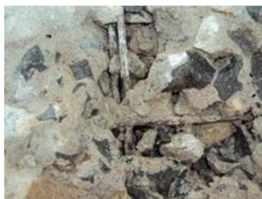
**Figura 36** – Vibração inadequada do concreto, proporcionando nichos de concretagem
