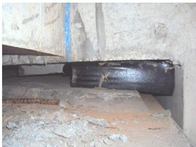
**Figura 5** – Aparelho de apoio deslocado da posição de projeto, ocasionando concentração de carga somente de um lado
