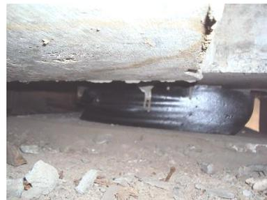
**Figura 7** – Rotações exageradas da viga longitudinal, provocando excentricidade no aparelho de apoio, com excesso de concentração de carga somente de um lado
