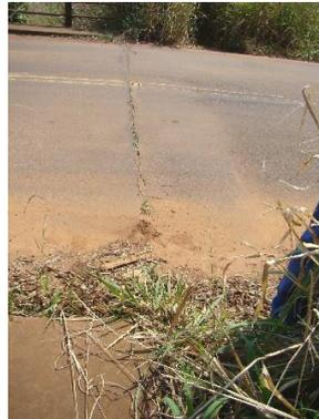
**Figura 18** – Junta de dilatação coberta com asfalto
