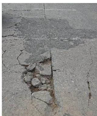
**Figura 41** – Partes soltas do pavimento de concreto.
