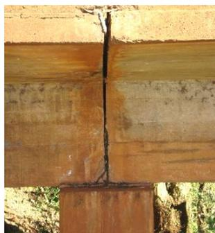
**Figura 30** – Fissuras no canto da viga, na região sobre o aparelho de apoio
