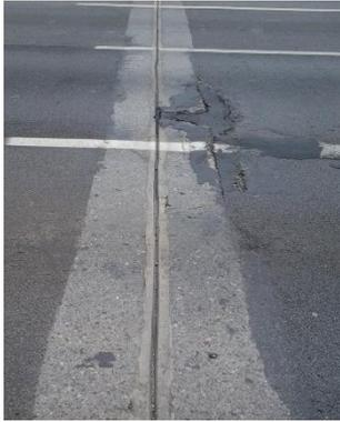
**Figura 14** – Berço de concreto, da região da junta, danificado e preenchimento asfáltico provisório no local danificado
