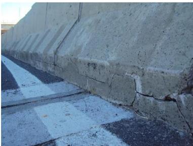
**Figura 17** – Barreira rígida (guarda rodas) instalado sobre a junta de dilatação
