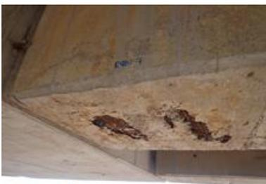
**Figura 35** – Falha de concretagem devido ao excesso de armaduras, não permitindo a passagem do concreto na região inferior de viga de ponte
