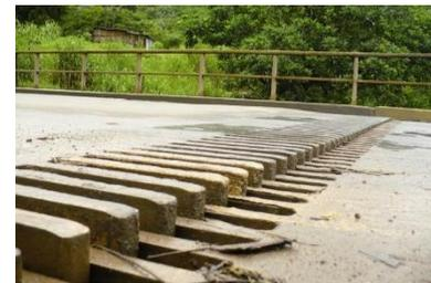
**Figura 19** – Junta de dilatação dentada com desnivelamento, provocando risco de acidente
